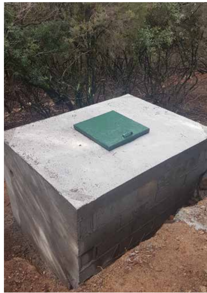
Fosse maçonnée pour déchets de venaison. Ci-dessus la fosse de l'association de chasse U Casile à Cauro
