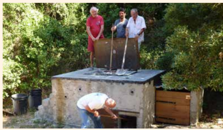
Des nouvelles fosses pour éliminer les déchets ont été installées dans 5 micro-régions après celle de Tominu (ci-dessus).
